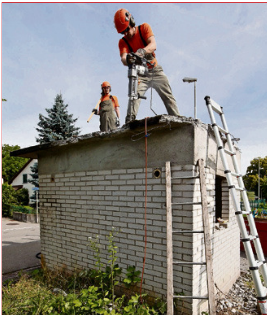
Die Zivilschützer aus Rümlang, Oberglatt, Niederglatt und Niederhasli nutzen alle Gerätschaften zum Abbruch des Feuerwehrhäuschens. Bilder: Balz Murer
