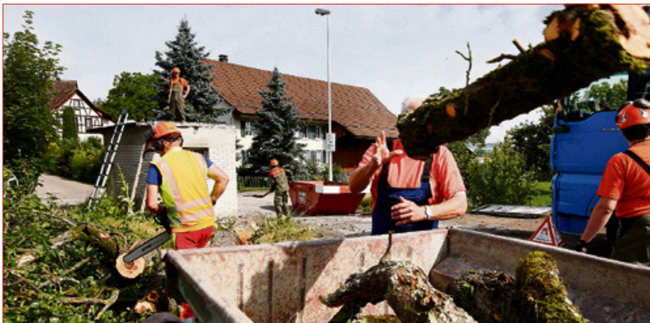
Bevor das alte Spritzenhäuschen abgerissen werden kann, muss noch ein Baum gefällt werden.
